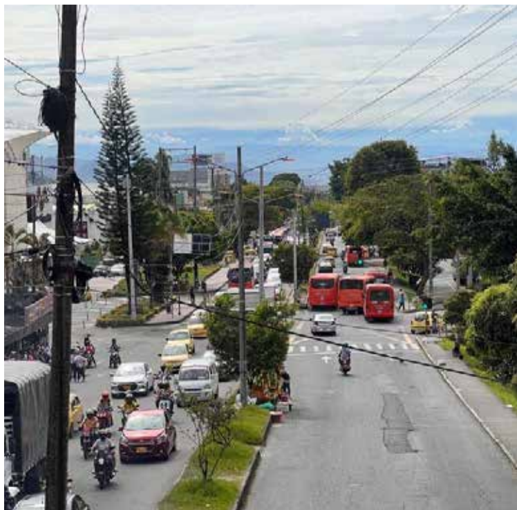
Van dos meses transcurridos y aún no se inician las obras del Puente de la carrera Quinta con calle 60 de Ibagué.
